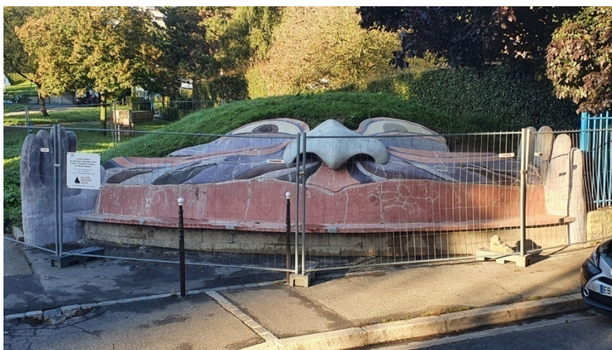
Après nettoyage, consolidations, bouchages et réfections.
