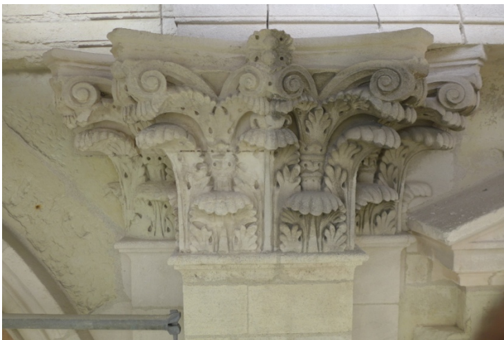
Chapiteaux extérieur à mi-nettoyage.
