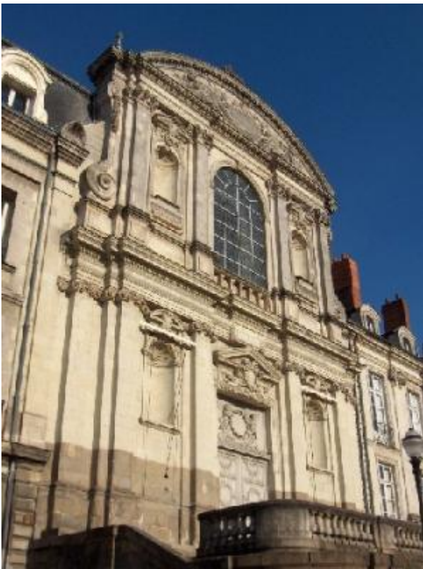
Vue d'ensemble de la façade ouest.
