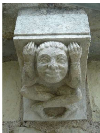
Modillon en cours de nettoyage.
