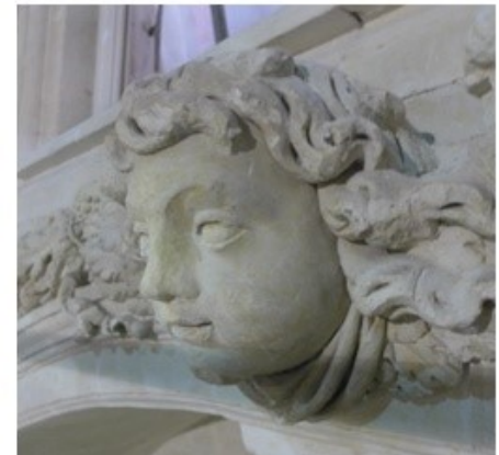
Angelot intérieur, en cours et après restitution et mise en couleur du nez.
