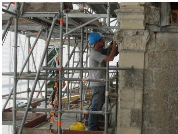
Nettoyage en cours (©photo Julien Coquet 2015).
