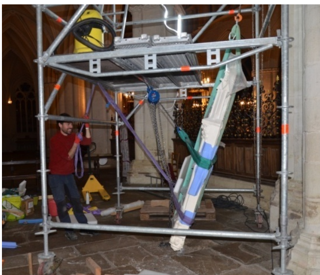
En cours de manipulation pour accrochage (double palan).
